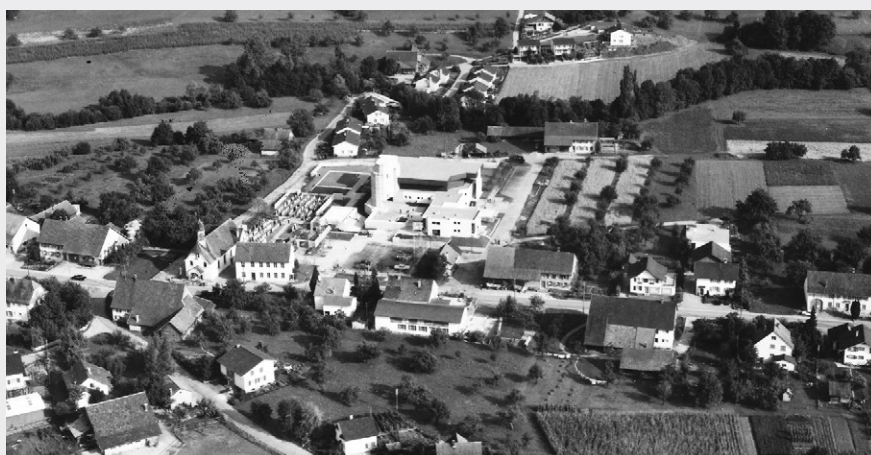
Im Hintergrund der Bau der neuen Kirche St. Wendelin.
