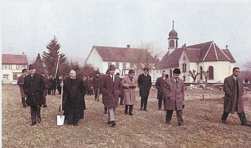
Spatenstich für die neue Kirche. Albert Hort, Rektor der Schule Frick, Dr. Anton Egloff, Pfarrer von Gipf-Oberfrick, Adolf Suter, alt Gemeindevorsteher (von links).
