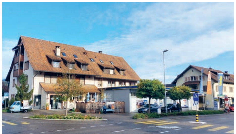
Diese beiden Gebäude an der Landstrasse 36 und 38 gehören der Baugenossenschaft Gipf-Oberfrick.
