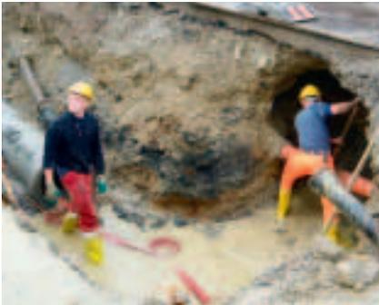
*Beim Einbau der neuen Wasserleitung stiess man auf der Höhe Haus Siegfried Mettauer auf viel Grundwasser, was die Arbeit erschwerte.*
