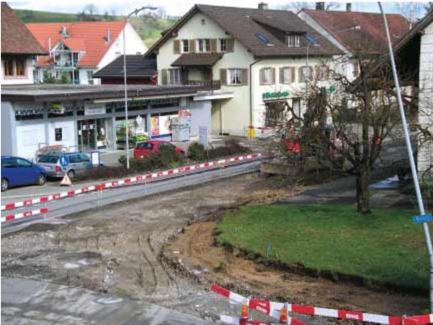
Radfahrer. Ersetzt werden die Hauptwasser- und Saubewasserleitung sowie die Strassenbeleuchtung. Gleichzeitig wird neu eine Gasleitung verlegt. Strasseneinfahrten werden saniert und und Aufwertungsmassnahmen realisiert.
