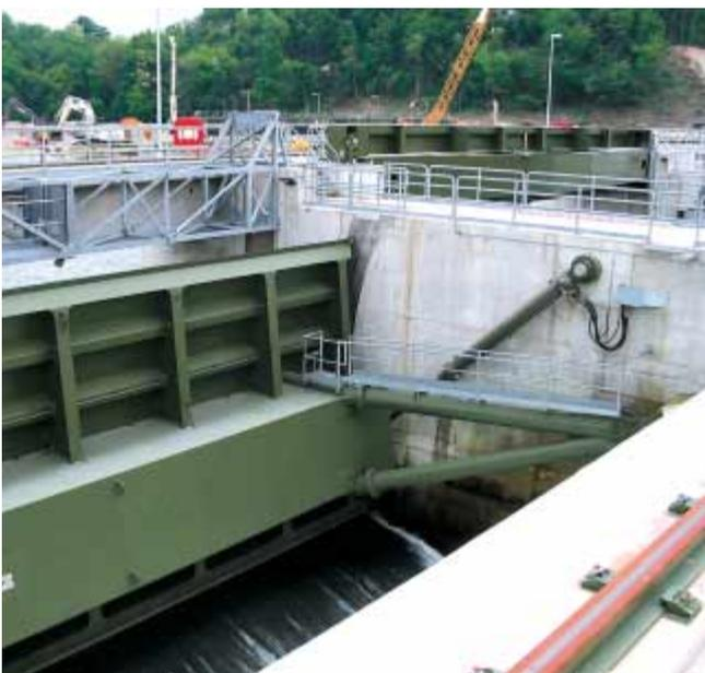
7 neue Wehrschützen regeln die Wassermengen zu den Turbinen. Sie vermögen auch ein Hochwasser von bis zu 5400 m<sup>3</sup> Wasser pro Sekunde sicher abzuführen.
