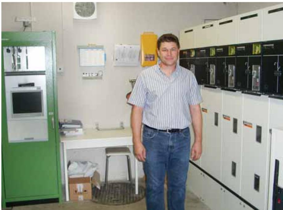
*Urs Rickenbach, Betriebselektriker der EGO, in der Transformatorstation Bleumatt. Die TS Bleumatt ist eine von 18 Trafostationen auf dem Gemeindegebiet. Sie ist zugleich die Mittelspannungsschaltanlage für das Gesamtnetz der Elektra Oberes Fricktal. Hier werden die Schaltzeiten gesteuert und die Lastverlaufskurven optimiert.*
