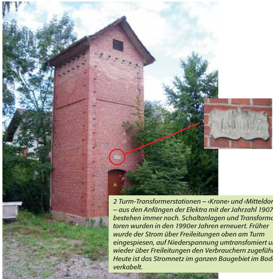
2 Turm-Transformerstationen – «Krone» und «Mitteldorf» – aus den Anfängen der Elektra mit der Jahrzahl 1907 bestehen immer noch. Schaltanlagen und Transformatoren wurden in den 1990er Jahren erneuert. Früher wurde der Strom über Freileitungen oben am Turm eingespiesen, auf Niederspannung umtransformiert und wieder über Freileitungen den Verbrauchern zugeführt. Heute ist das Stromnetz im ganzen Baugebiet im Boden verkabelt.
