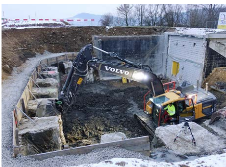
Aushub für neue Kammer und Hangsicherung.
