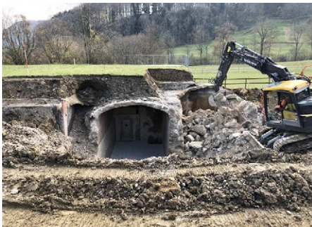
Abbruch alte und undichte Reservoirkammern.
